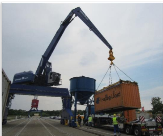
Verladevorgang bei der Wiederinbetriebnahme
