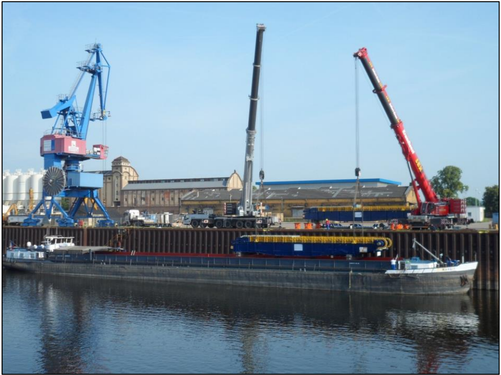
Verladung der Plattenbänder im Alberthafen Dresden (Foto: SBO)
